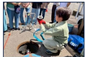
応急給水栓の設置方法を学ぶ
